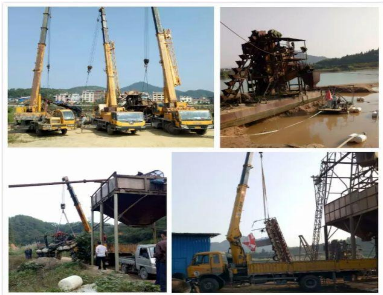
图为沙县涉砂整治现场
