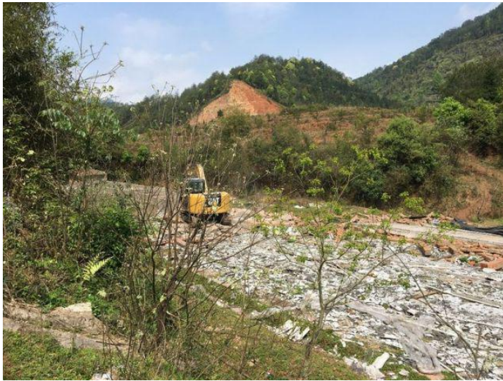
图为泰宁县大龙乡养殖场拆除现场
